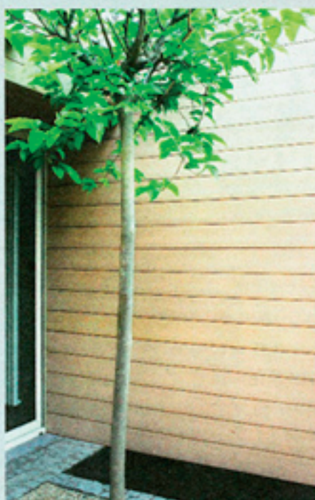
De gevelpanelen bevatten een mix van houtresten en kunststof. Ze zijn eenvoudig te plaatsen. Foto's KOS
