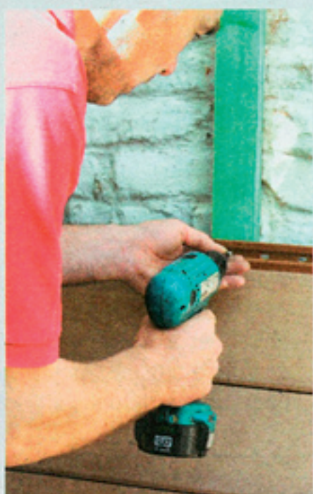
De gevelpanelen bevatten een mix van houtresten en kunststof. Ze zijn eenvoudig te plaatsen. Foto's KOS
